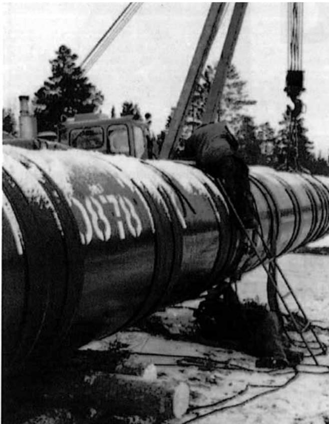
Fig. 3 — Um local de soldadura de tubulações na Rússia onde o FAMILIARC™ LB-52U é usado para unir as juntas de circunferência no tempo congelante
